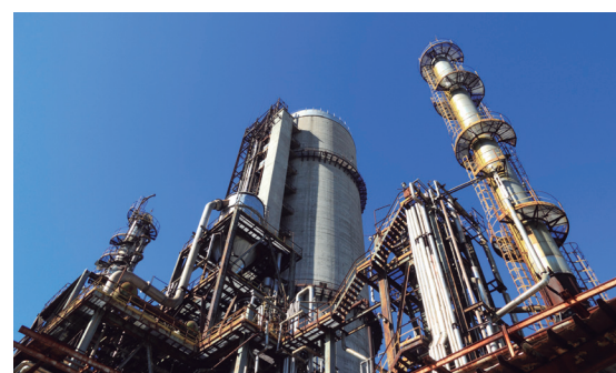
USINES PÉTROLIÈRES ESPAGNE
